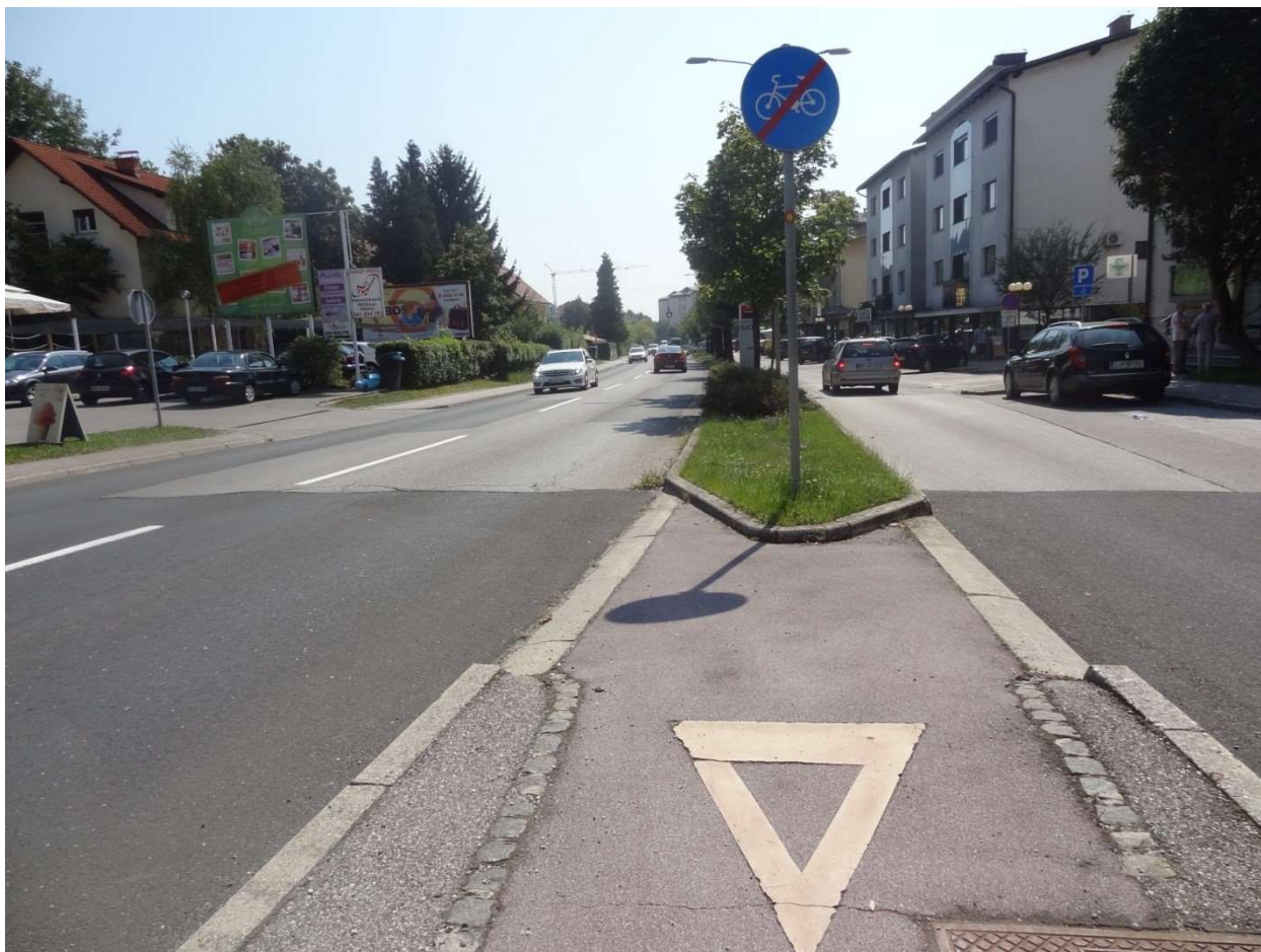
Nevarno vključevanje kolesarjev na cesto
